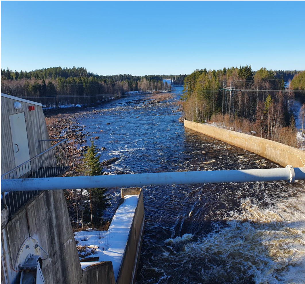
Kuva 55. Ajoittaiset ohjuksutukset muodostavat Nuojuan kuivauomaan hetkellisesti vuolaan kosken (kuvan aikainen juoksutus ~ 20 m 3 /s).
