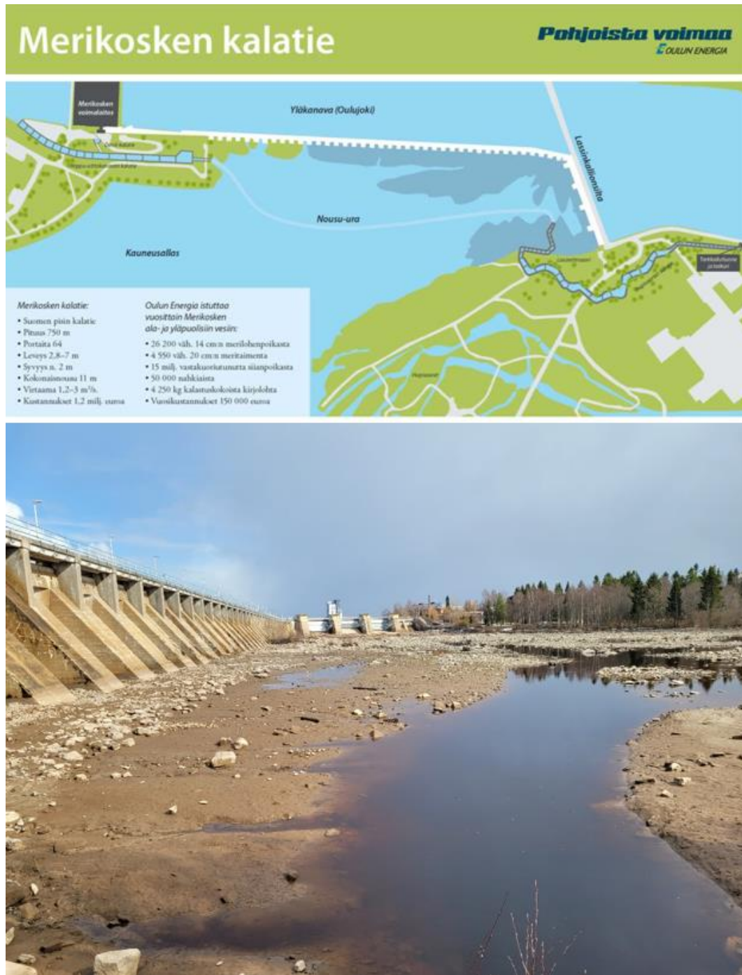
Kuva 5. Merikosken kalatien nousu-ura kulkee tarkastelualueen läpi. Alakuvassa on kalatien nousu-uraa voimalaitoksen puoleisen kalatieosuuden uloskäynniltä kuvattuna.
