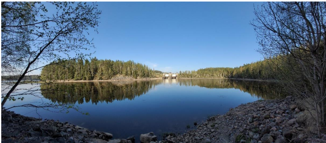
Kuva 15. Panoraamanäkymä tulvauoman alaosa juoksutusluukuille päin.
