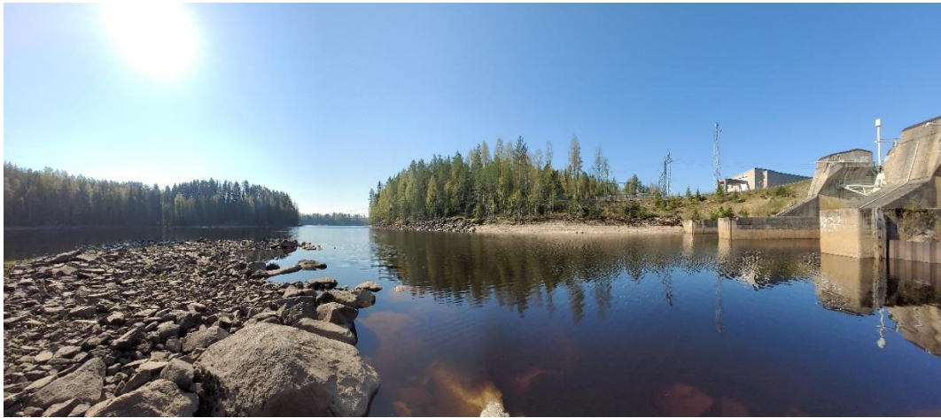
Kuva 14. Tutkittava kohde on ympärivuotisesti vedenalaista tulvauomaa. Voimalaitoksen lyhytaikaissäännöstelyt ja kokonaisjuoksutukset aiheuttavat huomattavia muutoksia alakanavan vedenpinnan tasoihin ja virtausolosuhteisiin.
