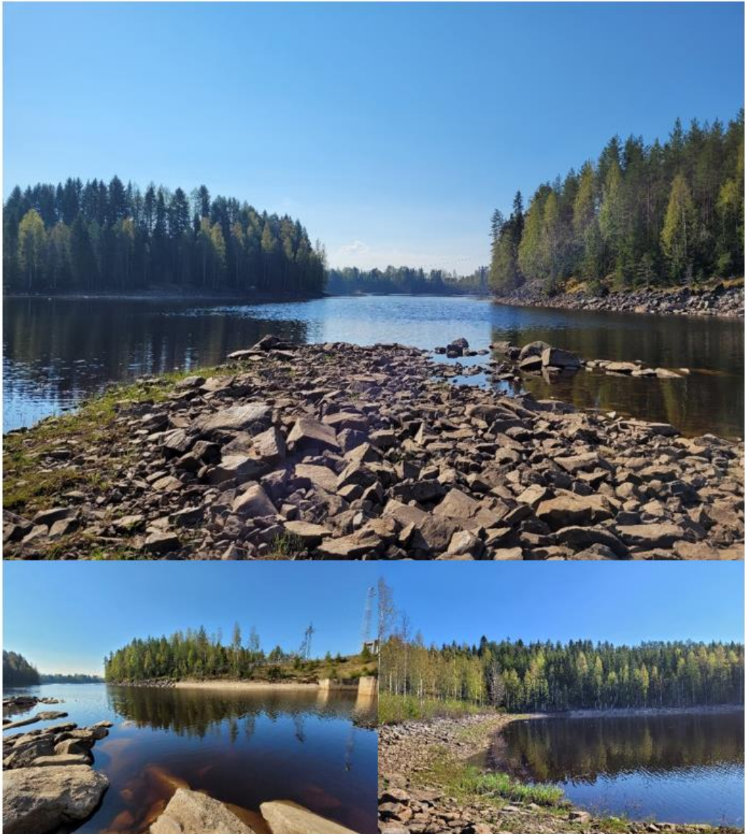
Kuva 17. Ylhäällä näkymä juoksutusluukkujen viereltä alavirtaan. Kivikkoinen pieni niemeke näkyy selkeästi satelliittikuvissa ja jatkuu vedenalaisena matalikkona alavirtaan. Matalikko on alakanavassa juoksutuksien purkautumisväylän ja suvantoisen ranta-alueen välissä (alakuviassa).
