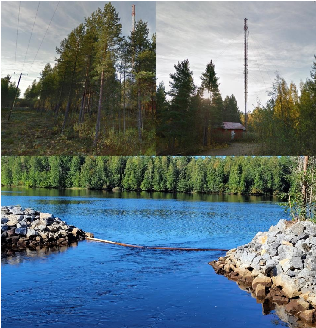
Kuva 42. Utasen voimalaitoksen itäpuolista suunnittelualuetta. Ylhäällä mahdollisen koskivyhteyden läheinen voimalinja ja verkkomasto. Alhaalla uuden lisävesiputken vedenottorakennetta, joka on tarkasteltavan koskivyhteyden yläjuoksun kohdalla. Yläkuvat: Google Maps.
