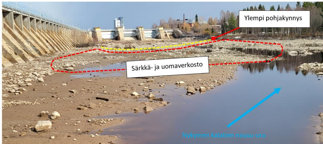
Kuva 10. Ensimmäinen pohjakynnys ja sen alapuolinen särkästö sijoitetaan voimalaitoksen puoleisen kalatien uloskäynnin yläpuolelle (lopullinen sijoitus määräytyy virtausmallinnuksen perusteella).
