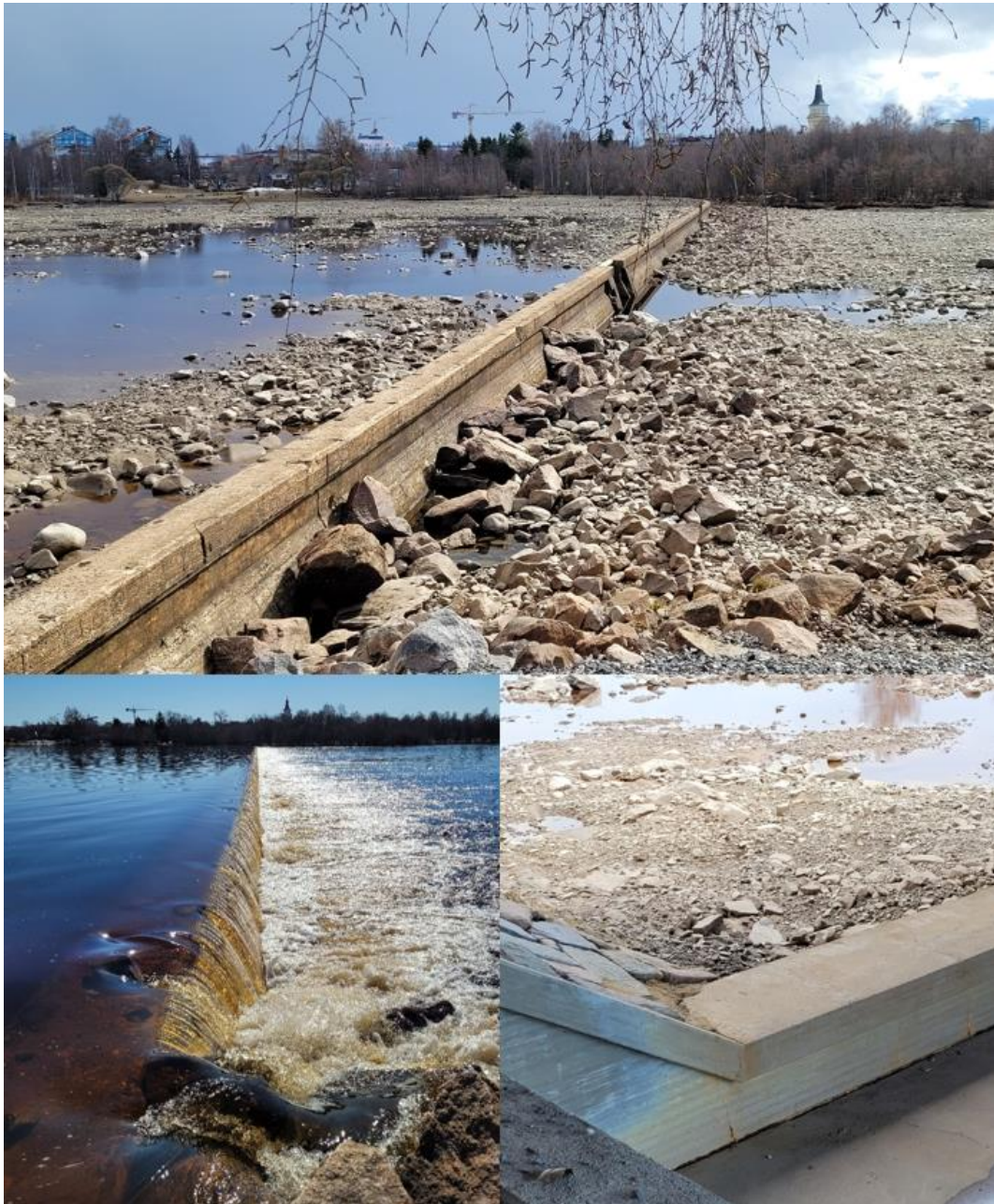
Kuva 4. Esiselvityskohde on vanhasta koskipohjasta allastettua ja pohjapadoin säännöstelyä vesistöä.
