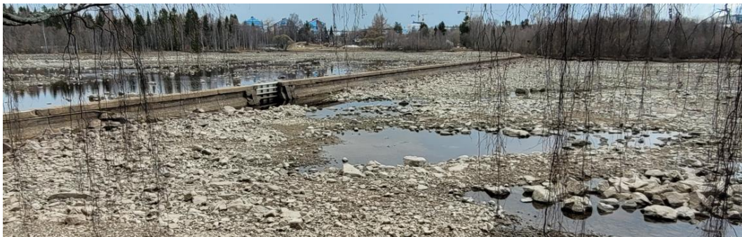
Kuva 11. Toinen pohjakynnys toteutetaan nykyistä kauneuspatoa madaltamalla ja purkamalla betonirakennetta osittain, mutta jättäen vanhaa betonia kynnyksen sydämeiksi.
