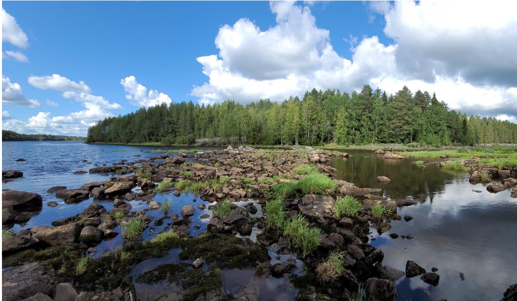
Kuva 56. Nuojuan kuivauoman alaosuutta. Voimalaitoksen juoksutusluukut tulevat kuvaa katsoen oikealle päin ja pääuoma on nähtävissä vasemmalla. Vanhaa koskipohjan kivikkoa on havaittavissa aina kuivauoman alajuoksulta juoksutusluukuille saakka.
