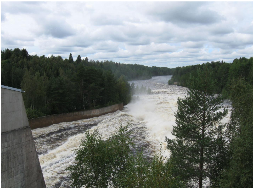
Kuva 25. Pällin voimalaitoksen ohjuoksutus 12.8.2012 (~ 300 m 3 /s). Kuva: Wikipedia.
