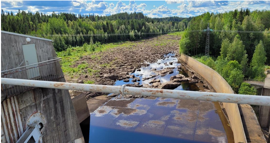
Kuva 57. Näkymä juoksutusluukkujen alapuoliselle alueelle.
