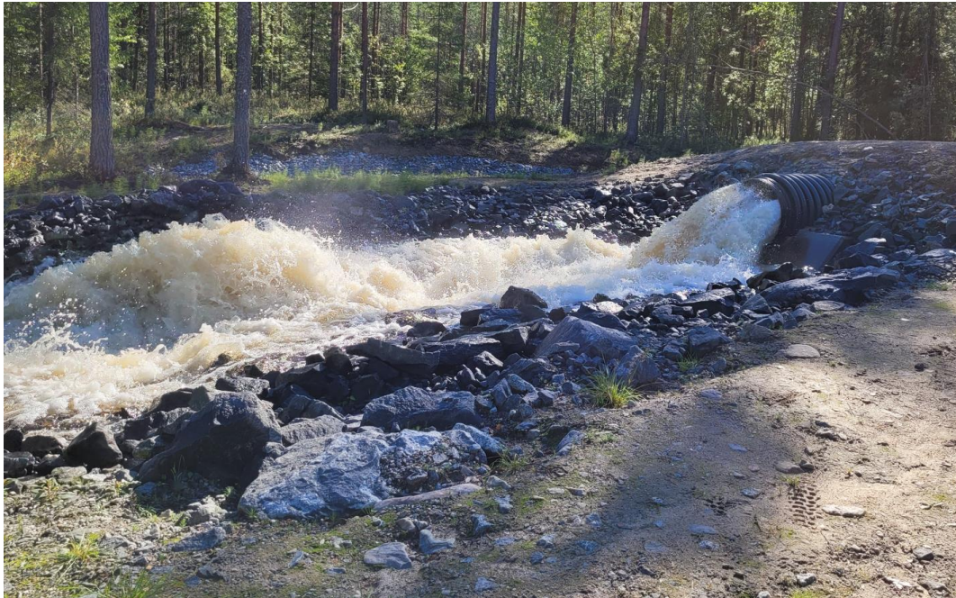
Kuva 44. Utajärven lisävesiputki johtaa noin 1,7 \text{ m}^3/\text{s} suuruisen virtaaman Utasen voimalan yläkanavasta Utajärven altaaseen.
