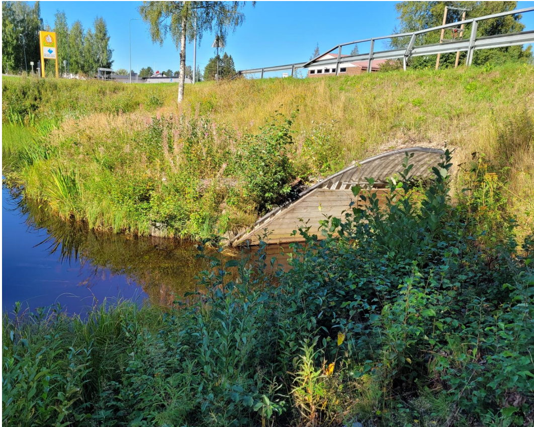
Kuva 38. Puolangantien rumpusilta Utajärven kunnan keskustassa.
