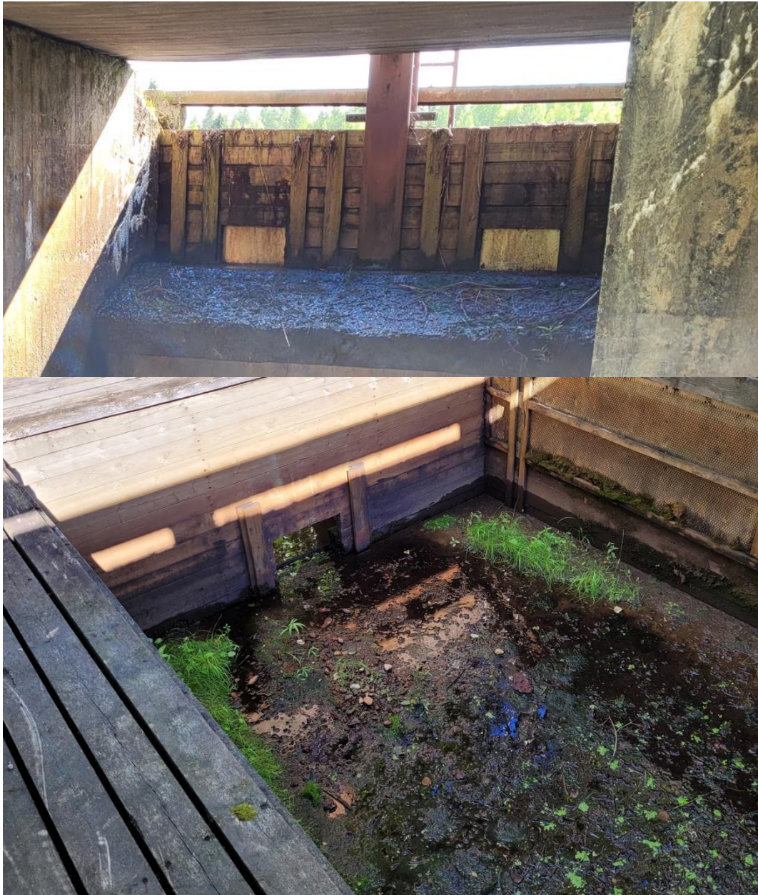
Kuva 65. Jyrkänlammen luonnonravintolammikon alapuolinen säätö rakenne ja kalojen keräysallas.
